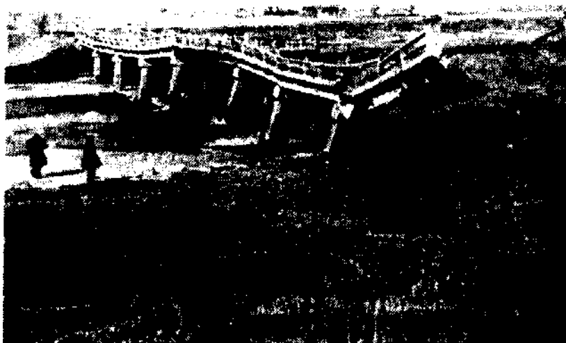
شکل ۱۳- خرابی پل در چین (زلزله هایچنگ ۱۹۷۵)
